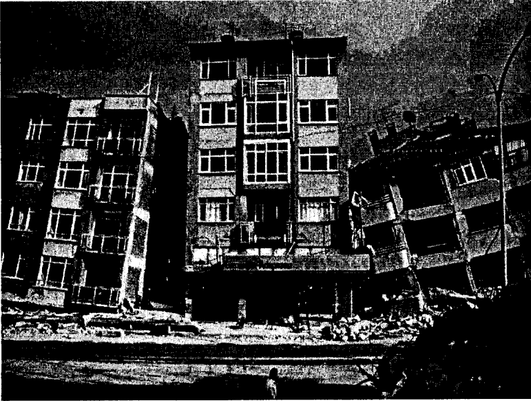
Şekil 4. Yapısal sistem göçmesi formunda yapı hasarları.
