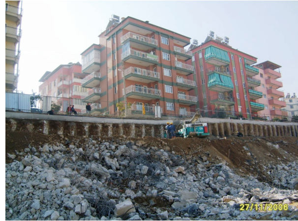
Şekil 1. Uygulamanın yapıldığı fore kazık ve ankraklı iksa sisteminin yapımı.
