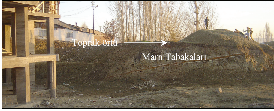
Şekil 2. Kılavuz mahallesinde temel inşaatı ve marn tabakaları
