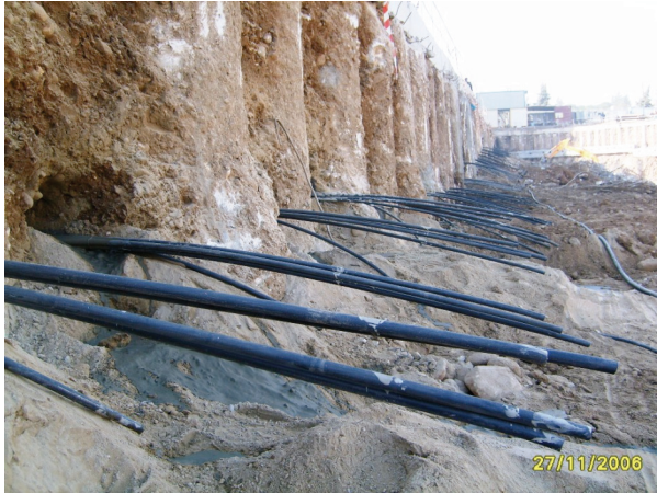
Şekil 1. Uygulamanın yapıldığı fore kazık ve ankraklı iksa sisteminin yapımı.
