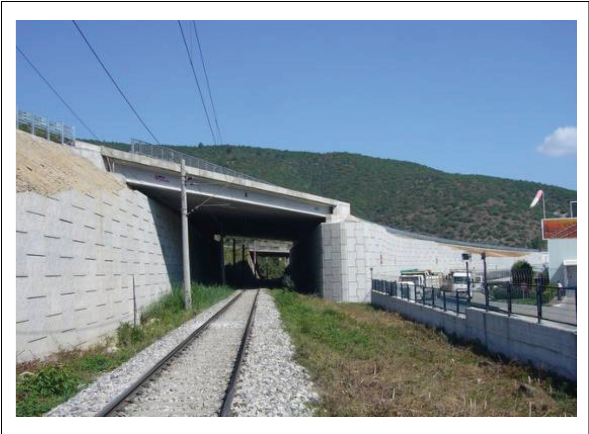
Şekil 10. DDY Altgeçit Köprüsünün Bitmiş Hali
