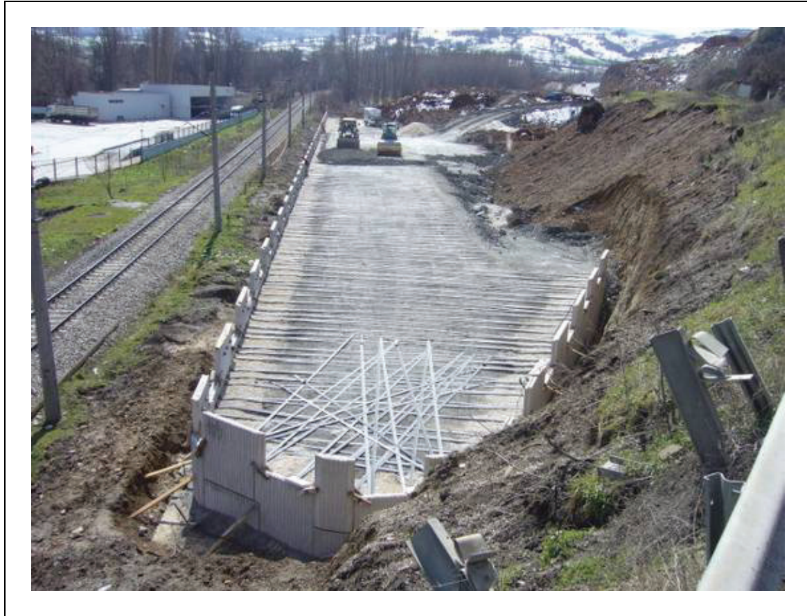
Şekil 8. DDY Altgeçit Köprüsü A1 Kenarayak ve Duvar No:4 Şerit Montajı
