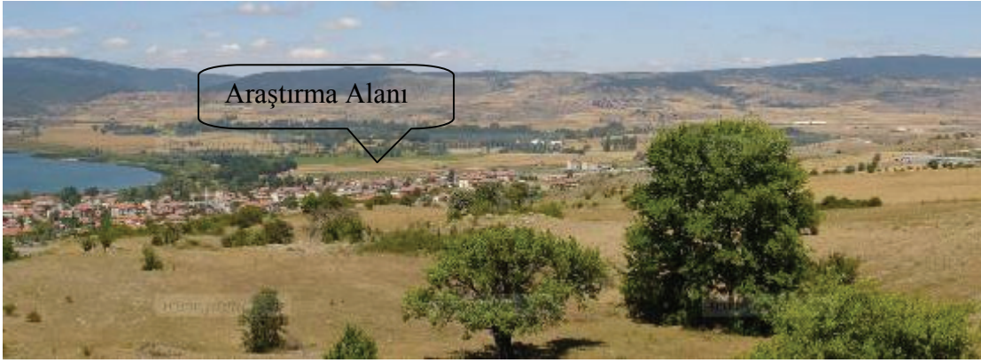
Şekil 7. Çalışma sahasının güneyden görünümü.
