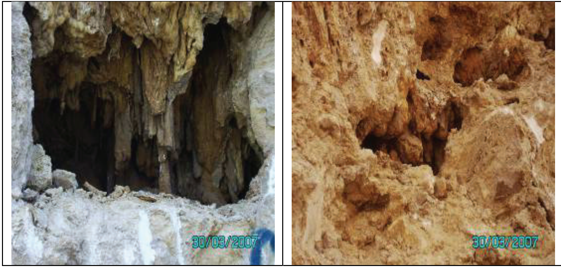
Şekil 3. a-b) Çalışma sahasında bulunan Karstik Boşluklar
