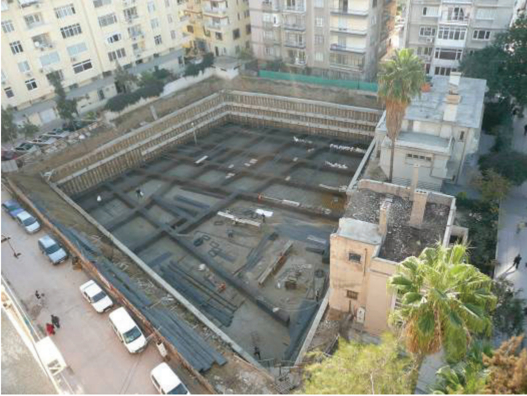
Resim 2. Mini kazıklı ankrajlı iksa sistemi
