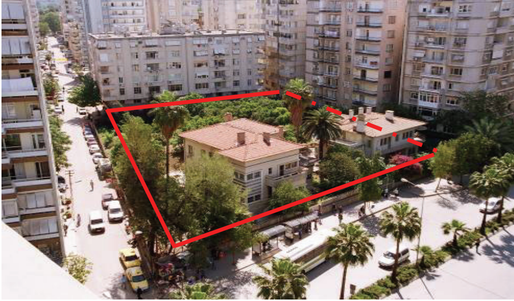
Resim 1. İnşaat alanı genel görüntüsü
