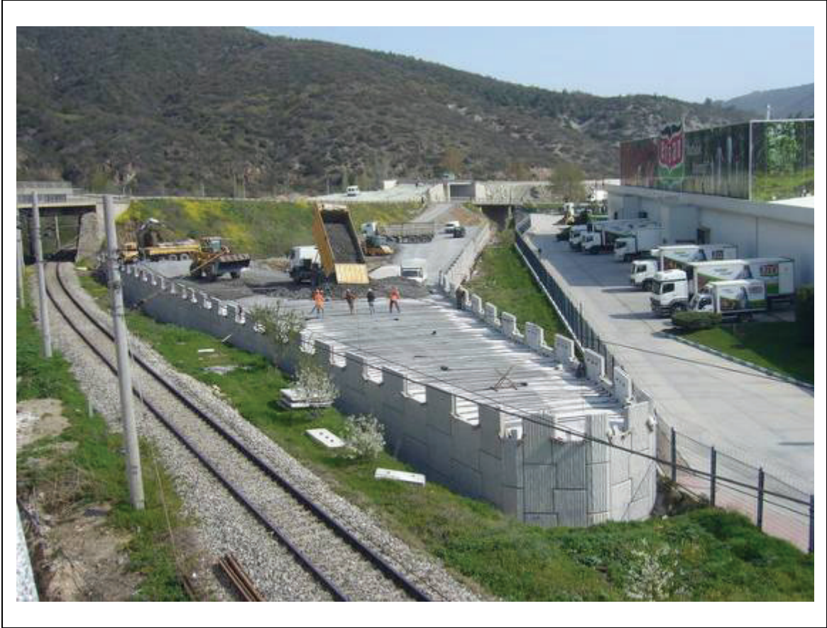
Şekil 9. DDY Altgeçit Köprüsü A2 Kenarayak ve Duvar No:2 Şerit Montajı
