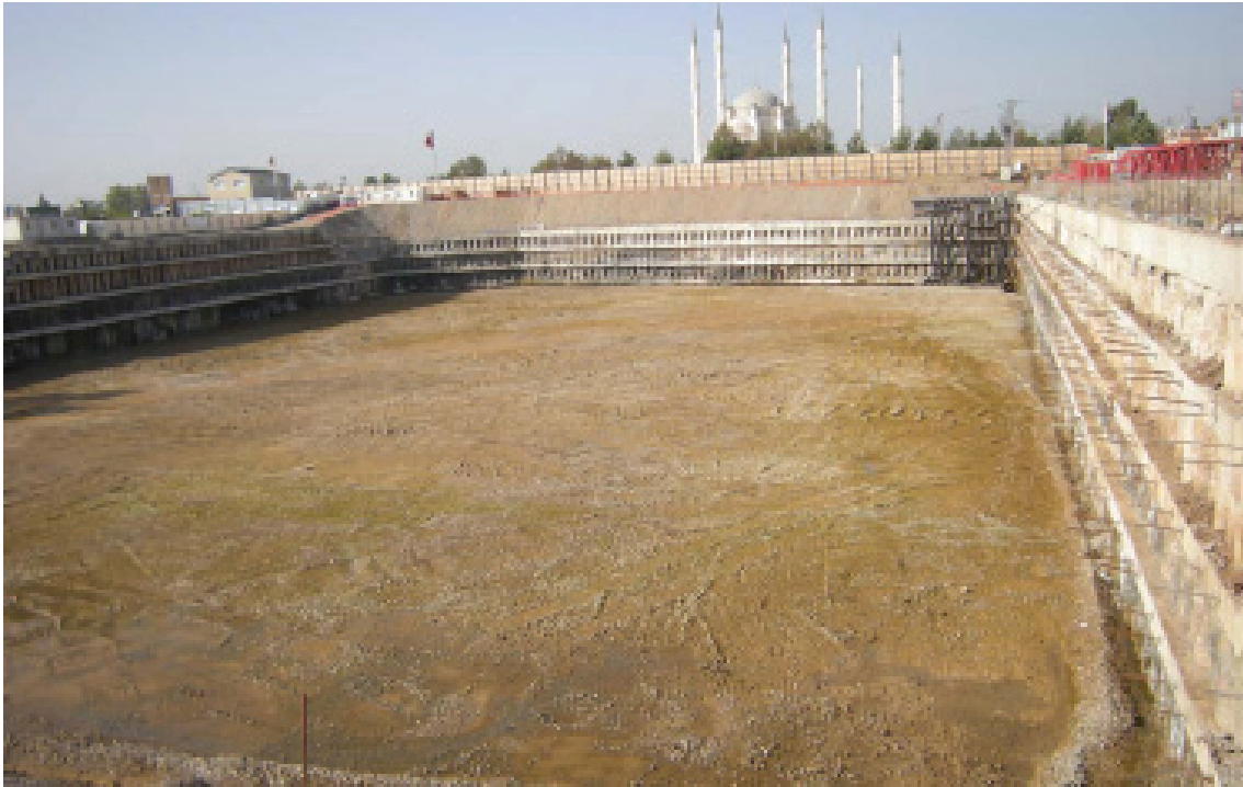
Şekil 6. Adana – Göksu AVM Kazı Çukurunun Tamamlanmış Hali
