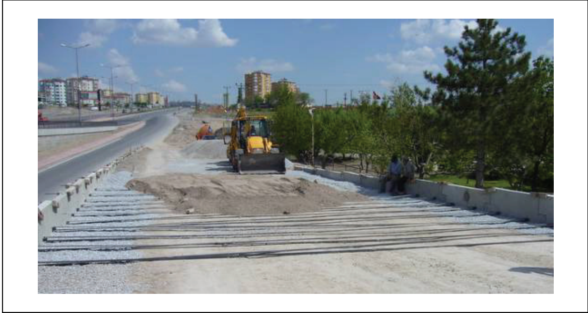
Şekil 13. Yanyol-1 Rampasında Şerit Montajı
