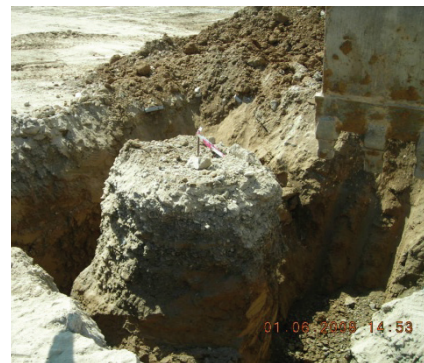
Şekil 4. Jet 1 Yöntemi ile imal edilen Jet Grout Kolonu
