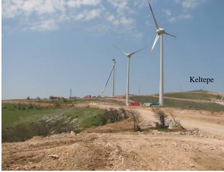
Fotoğraf 8. Susurluk/Keltepe’de Rüzgâr Türbini Montaj Çalışmaları (18 Nisan 2009).
