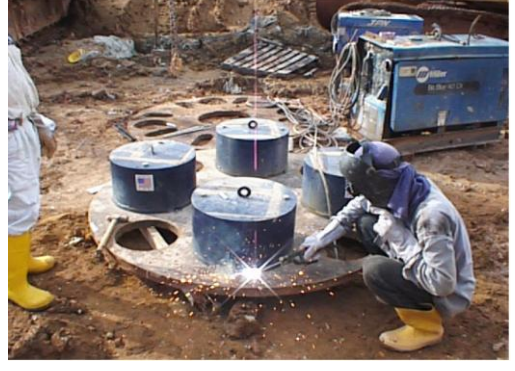
Şekil 18D Çoklu Hücre Montajı
