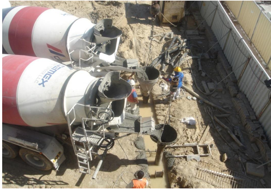
Şekil 15. Tremie Yöntemi ile Betonlama
