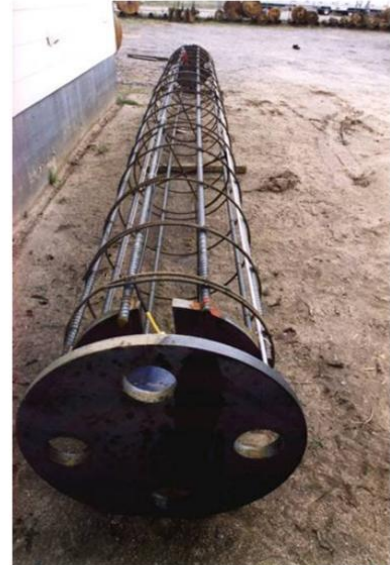
O-Cell/Plaka Donatı Kafesine Kaynakla Birleştiriliyor
