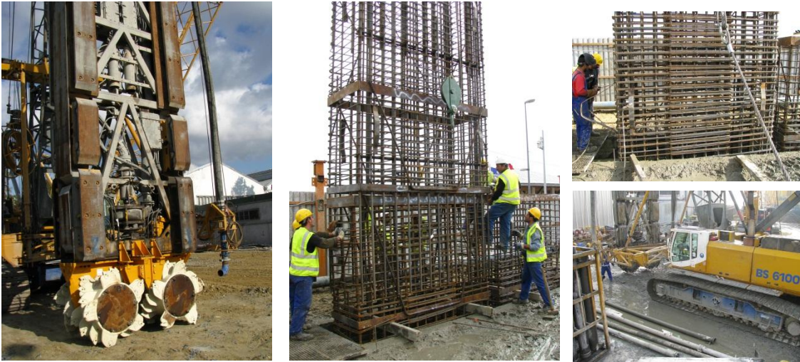
Şekil 5. Diyafram Duvar İnşaatı
