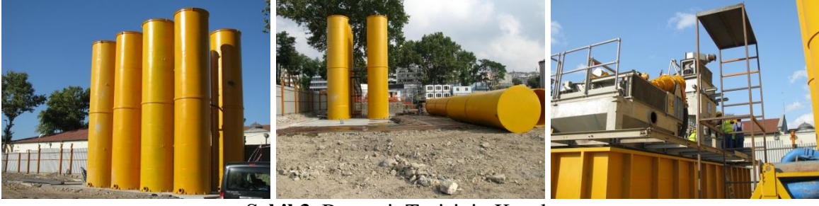
Şekil 3. Bentonit Tesisinin Kurulumu
