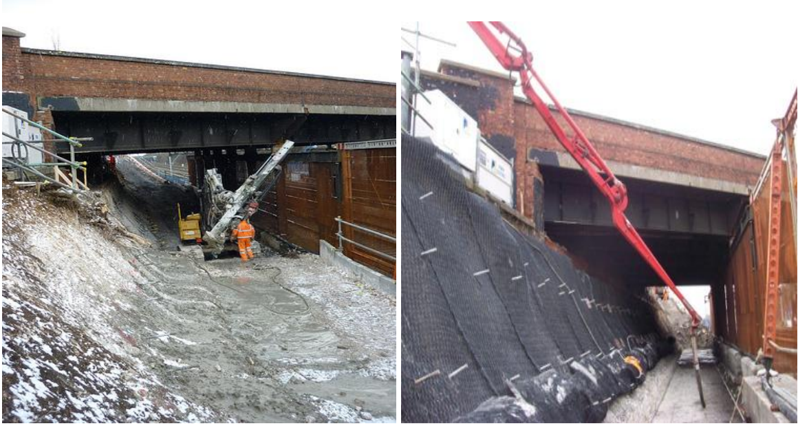
Şekil 5. Western Region Demiryolu Köprüsü - Zemin Çivileme İşlemleri ve Uygulama Sonrası (Anonim, 2011c)
