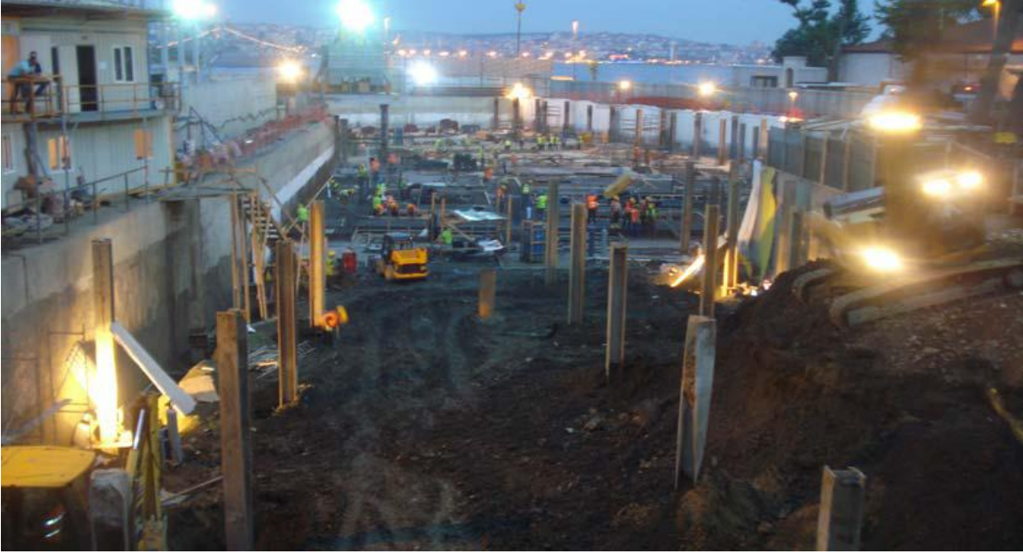
Şekil 7. Birinci Kademe Kazısı
