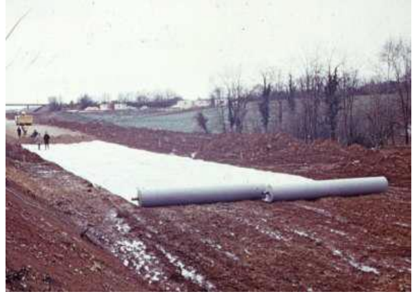
Şekil 5. Geotekstilin arazi uygulaması
