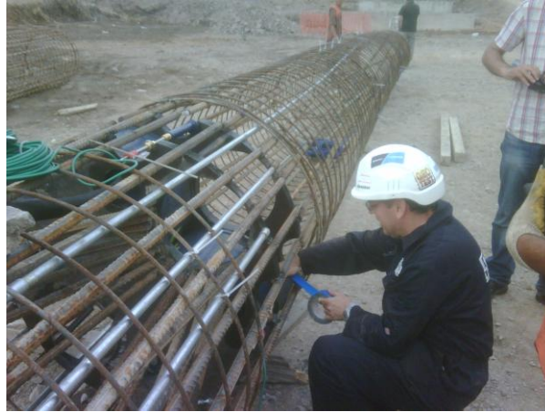
Şekil 2. Galvaniz Kılıf ve Ekstensometre
