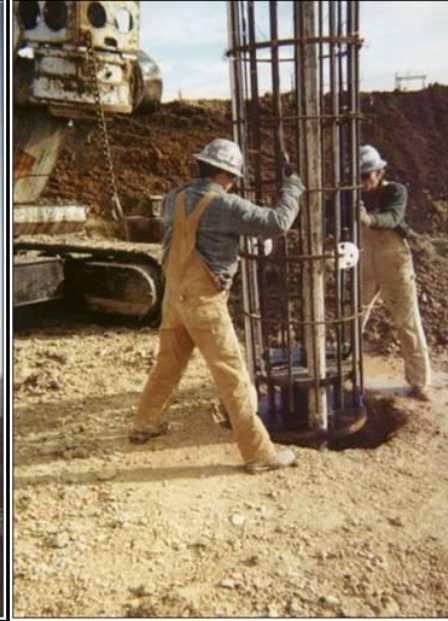
Şekil 18G Donatı Kafesinin Yerleştirilmesi
