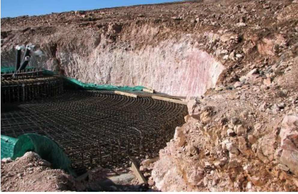
Fotoğraf 6. Mermer Üzerinde Açılmış Bir Rüzgâr Türbini Temel İnşaası (24 Ocak 2009).
