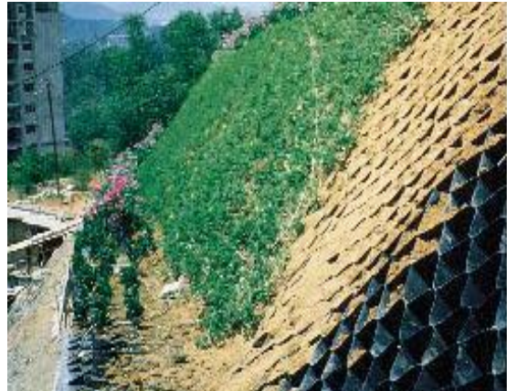
b. Şev Stabilitesini sağlama amaçlı kullanımı
