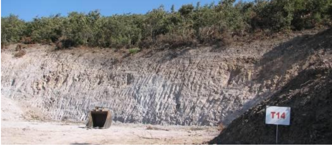
Fotoğraf 3. Sayalar A Bölgesi'nde Volkanik Kayalar Üzerinde Açılmış T14 Türbin Yeri. Bazaltik Andezit Kayasının Zeminin Üst Seviyelerinde Aşırı Ayrışma Görülmektedir (23 Ağustos 2007).
