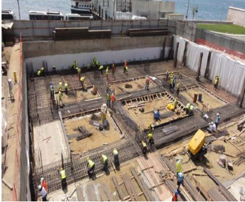
Şekil 8. Donatı Ve Kalıp İmalatı
