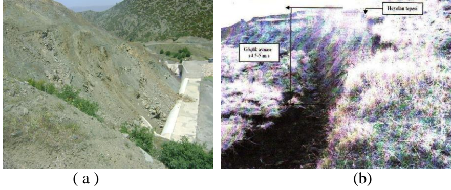
Şekil 2 (a) Dolusavak Teknesinin Heyelan Altında Kalması (b) Heyelan Taç Bölgesi
