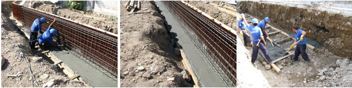
Şekil 2. Kılavuz Duvar İnşaatı
