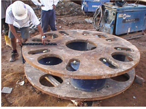
Şekil 18E Üst Plağın Bağlanması
