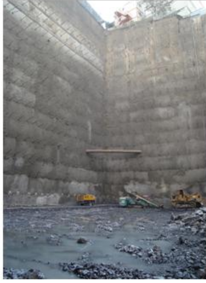
Şekil 9. Kazı Çukurunun İçten Görünümü
