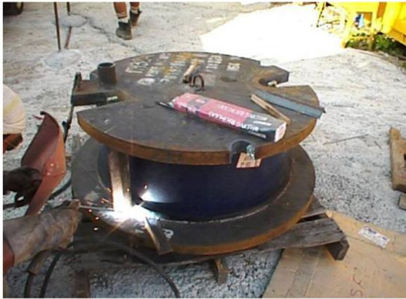
Alt ve Üst Tabakalar O-Cell'e Kaynakla Birleştiriliyor
