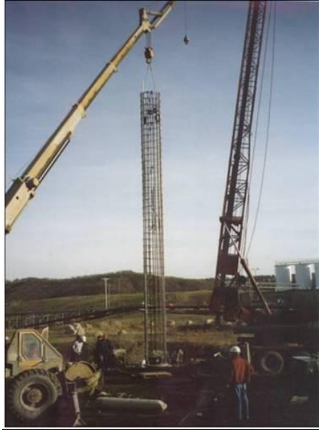
Şekil 18G Donatı Kafesinin Yerleştirilmesi
