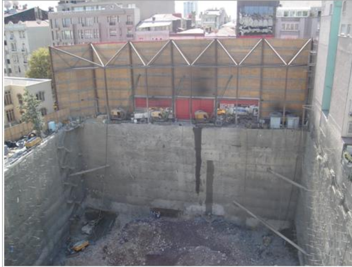
Şekil 11. Saha Sınırındaki Bina (Sağ Cephe)
