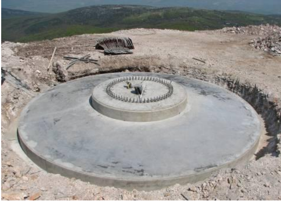
Fotoğraf 7. Susurluk Keltepe'de Mermerler Üzerine Oturtulmuş Bir Rüzgâr Türbini Temeli (18 Nisan 2009).
