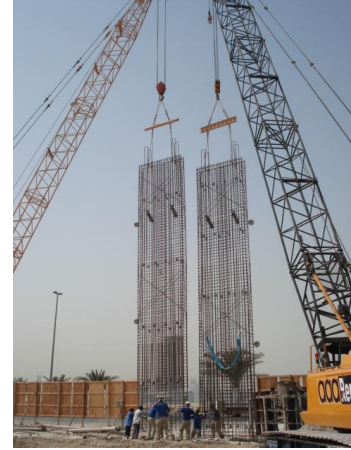
Şekil 14B. Donatı Kafesinin Askıya Alınması
