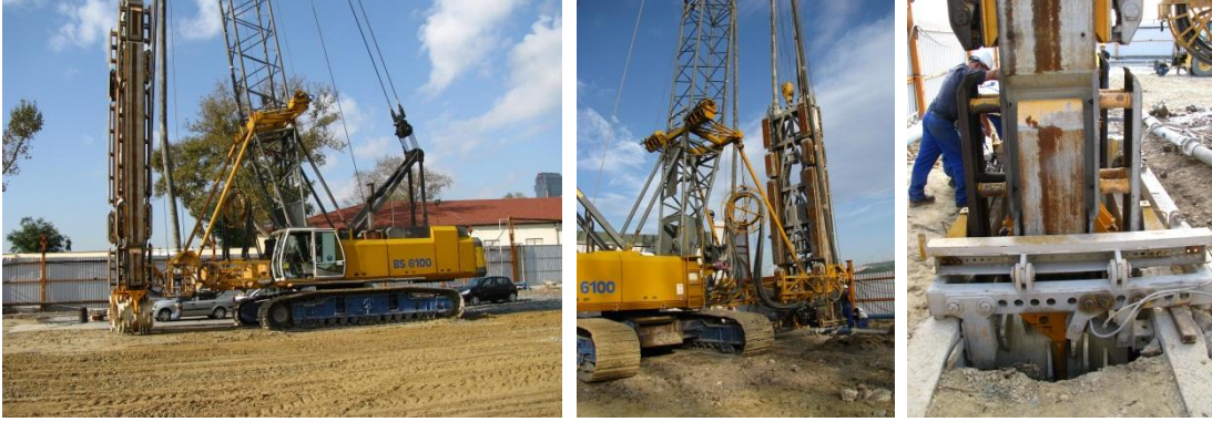
Şekil 4. Diyafram Duvar Makinesinin Çalıştırılması
