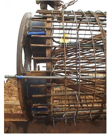
Şekil 18F Tremie için Klavuz Yapılması
