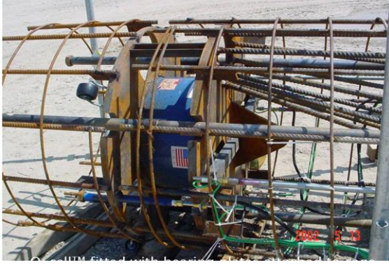
Şekil 18C O-Cell Test Ekipmanları
