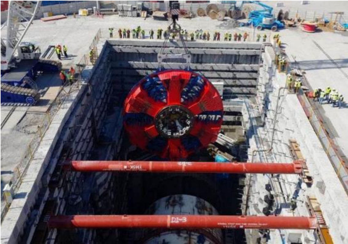
Şekil 13. ATB Sahası Giriş Ağzında TBM Makinesinin İndirilmesi
