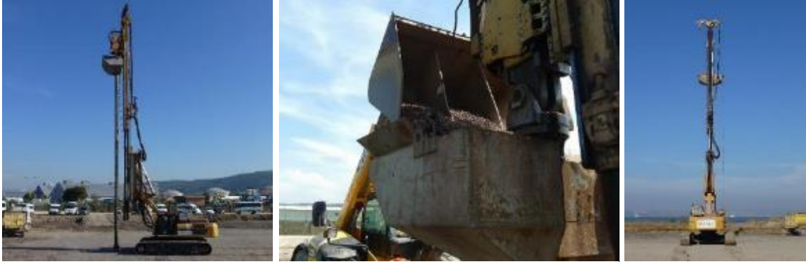
Şekil 3. Impact® Sistemi İle Darbeli Kırmataş Kolon İmalatı
