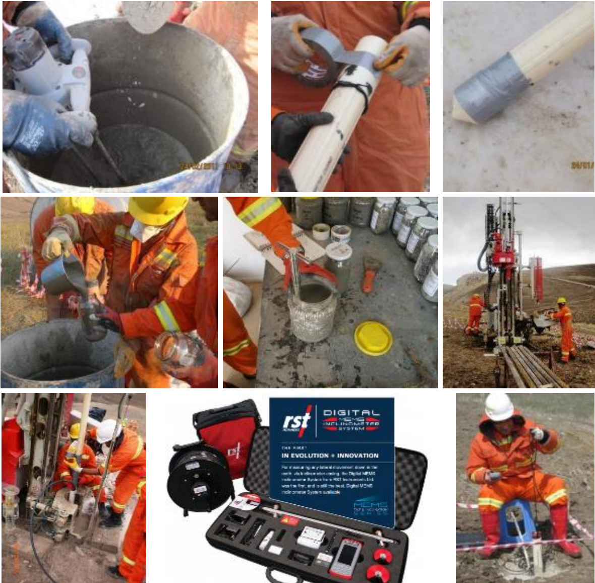
Şekil 2. İnklinometre Borusu Düşey Yerleştirme Adımlarının Şematik Görünümü
