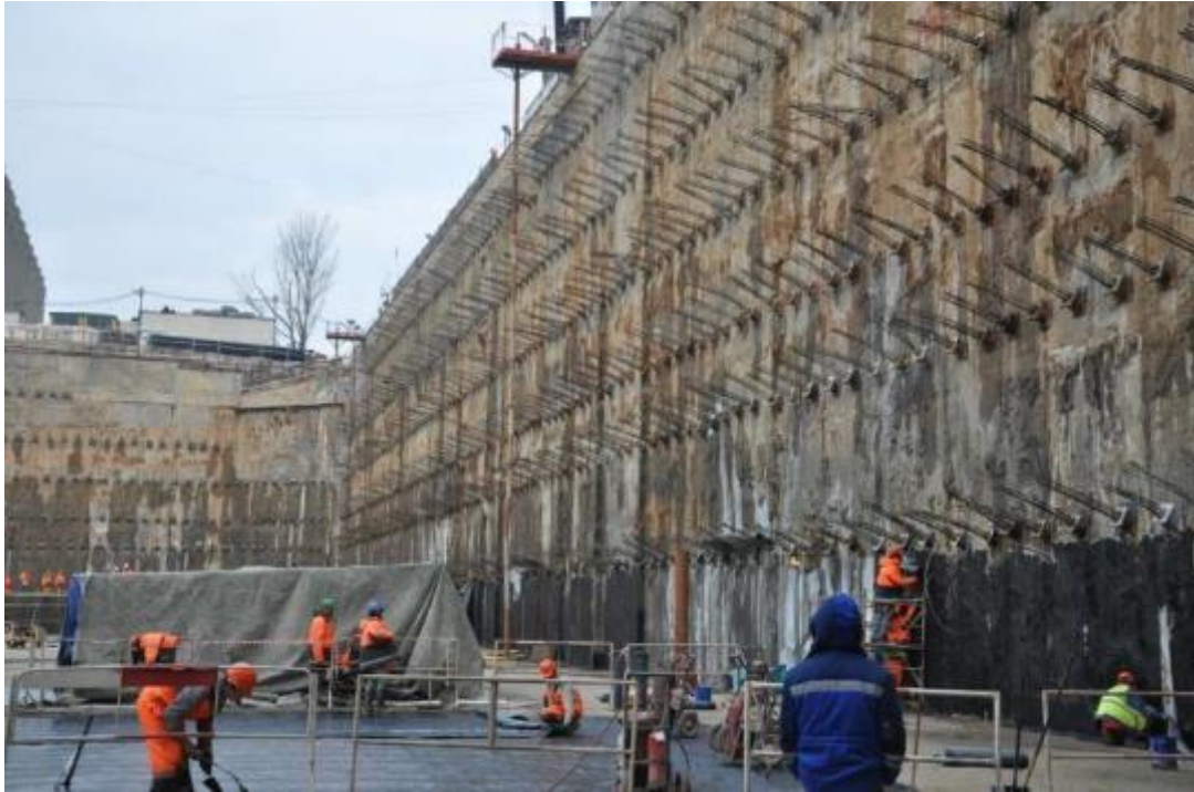
Şekil 14. 25m Derinliğindeki Kazıyı Destekleyen Diyafram Duvarlar SBMA Ankrajlar
