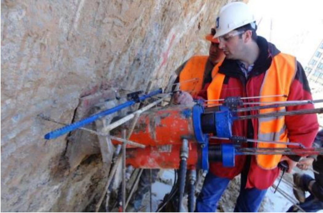
Şekil 11. SBMA'ların Hidrolik Senkronizasyonlu Krikolar ile Testi ve Gerilmesi
