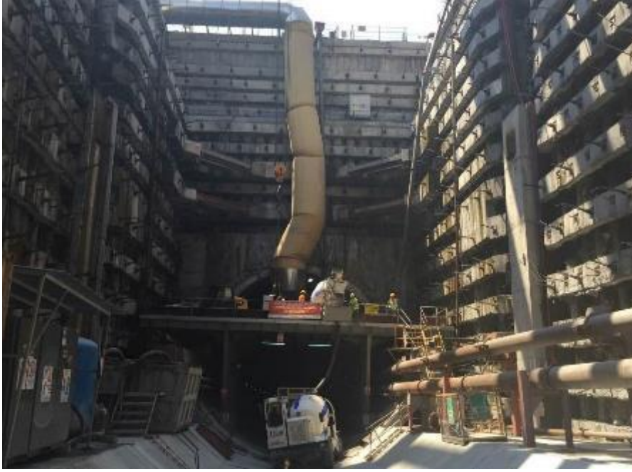
Şekil 14. ATB Kazı Çukuru Tamamlanan TBM Delgisinin Görünüşü
