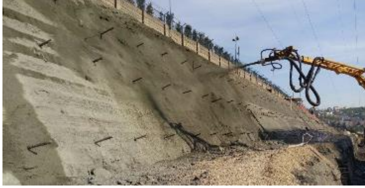
Şekil 14. Püskürtme Beton Uygulaması
