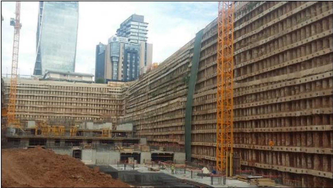
Şekil 3. Kazı Çukuru Temel Kotundan Görünüşü (Eylül 2015)
