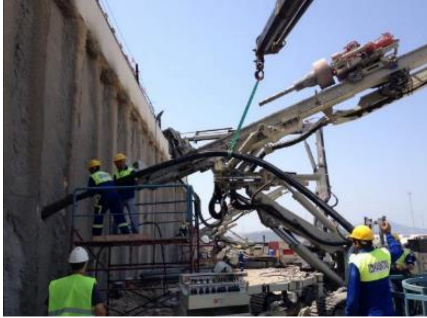
Şekil 30. Proje Ankrajları Halat Yerleştirme İşlemi
