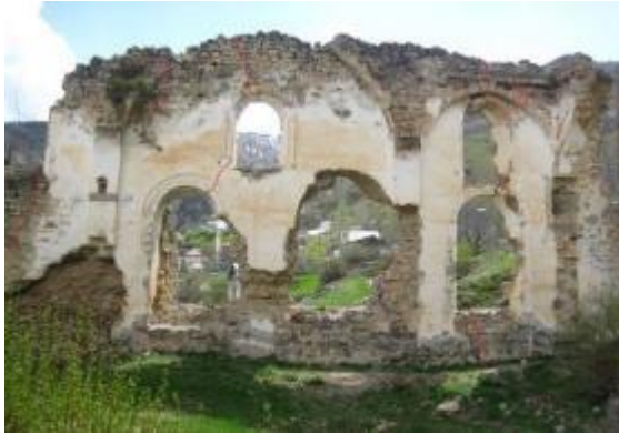
Şekil 8. Surp Karabet Kilisesi Güney Duvarı İç Hattı.
