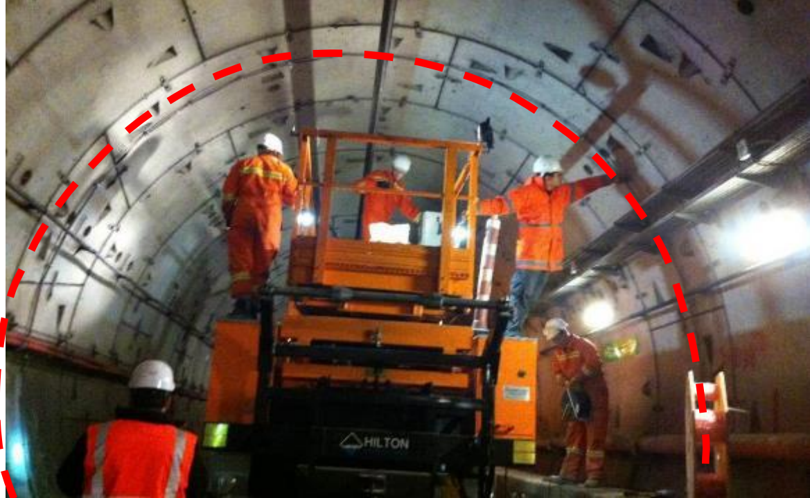
Şekil 17. Tünelde Konverjans ölçümü için SAA Yerleştirilmesi ile ilgili Tipik Görüntüler
