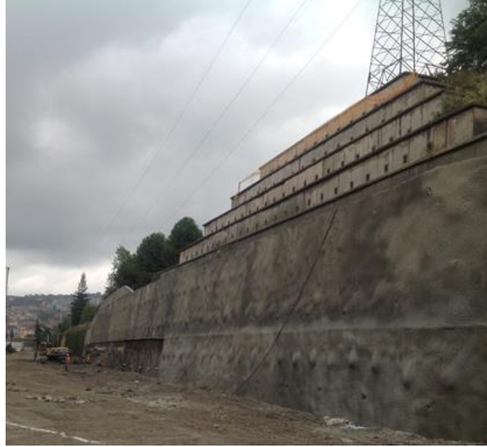
Şekil 15. Yüksek Gerilim Hattı Altında Yapılan İksa Yapısı Görünümü
