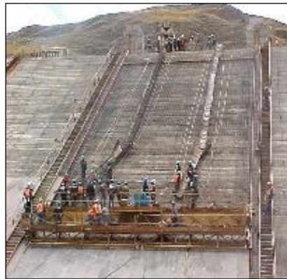
Şekil 4. Antamina Barajı Memba Yüzü Plağı İnşası, Düşey Derzler ve Çevresel Derz (109 m, Peru)
