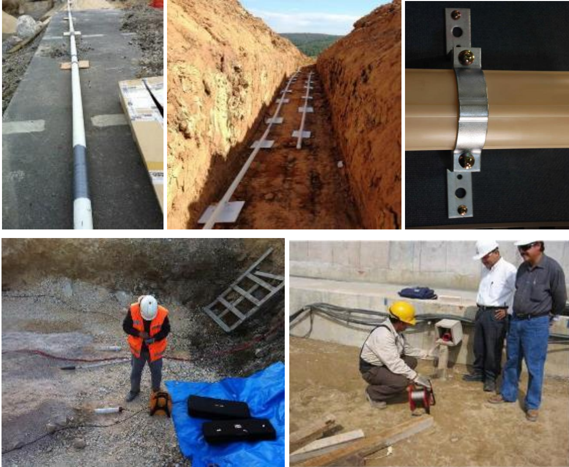
Şekil 11. İnklinometre Borusu Oturma Gözlemi için Yatay Yerleştirme ve Okuma Aşamalarından (inklinometre borularının birleştirilmesi, oturma plakası ve pozisyon kelepçesi, okuması alınması v.b.) Genel Görünüş
