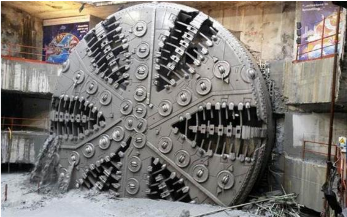
Şekil 17. ETB Kazı Çukuru TBM Çıkış
