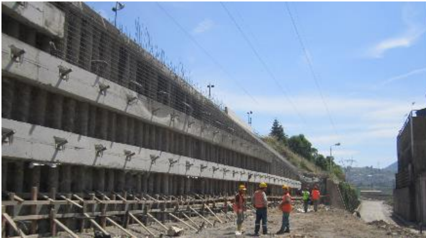
Şekil 8. Mini Kazık Kalıcı Ankraj Uygulaması
