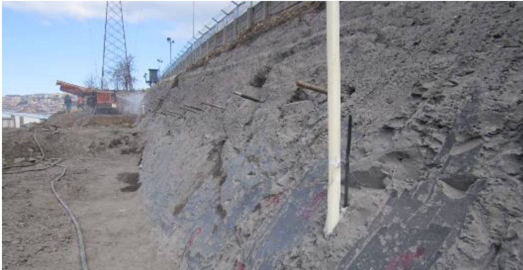
Şekil 7 Kazı – Pasif Ankraj – İnklinometre Çalışması
