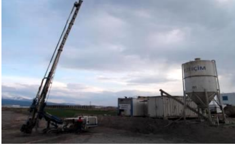
Şekil 2. Alibeyoğlu Hırdavat Anonim Şirketi'ne ait Toptan Ticaret Binası inşaat alanı
