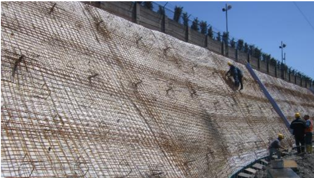
Şekil 11. Geokompozit Levha ve Donatı Montajı
