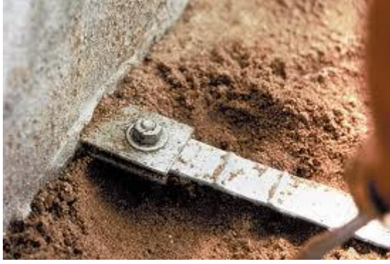
Şekil 4. Paraweb Polimer ve Çelik Şerit Bağlantı Detayları
