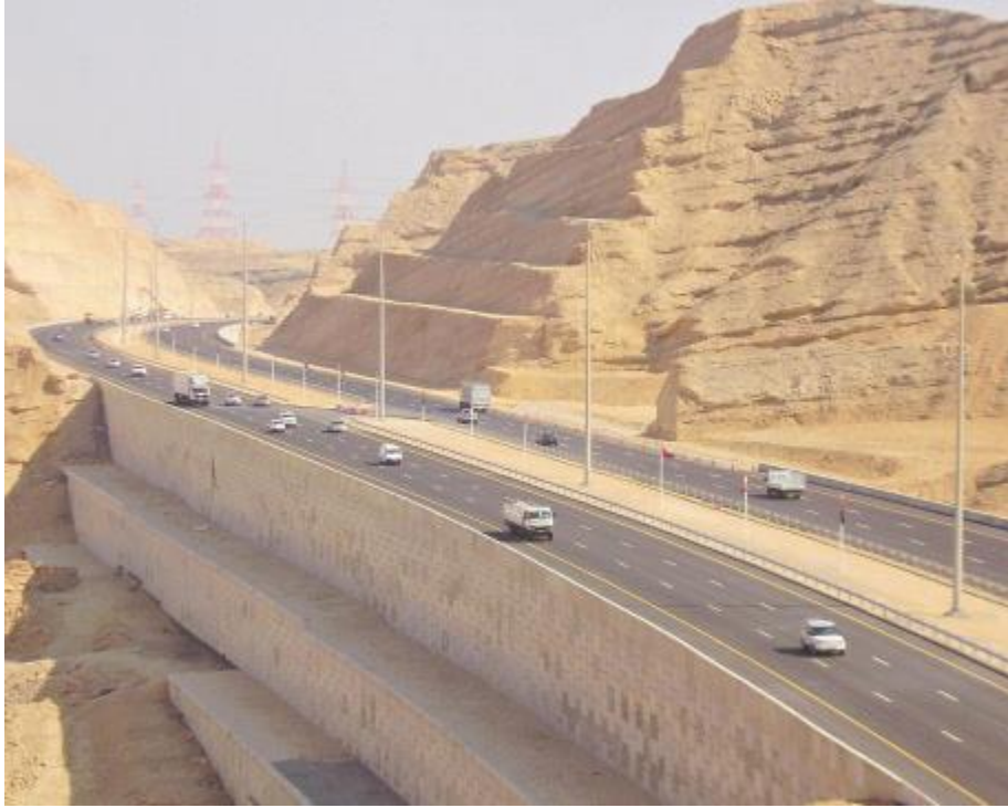
Şekil 8. Muscat Oman'da Panel ve Polimer Şeritler Kullanılarak Yapılan 56 m Yüksekliğindeki Duvarlar [7]
