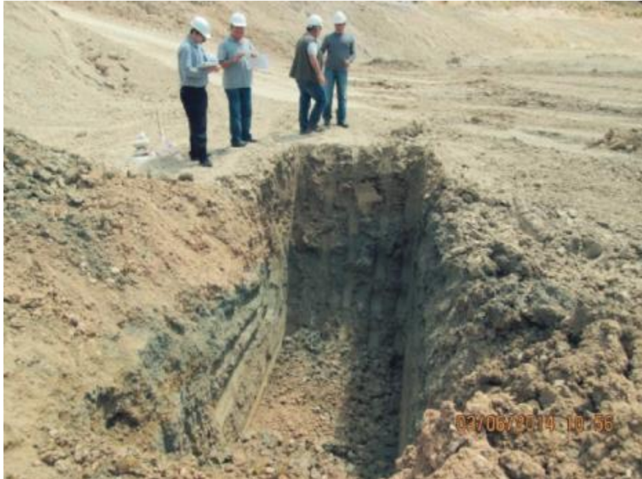
Fotoğraf 1. Araştırma Çukuru Çalışmaları
