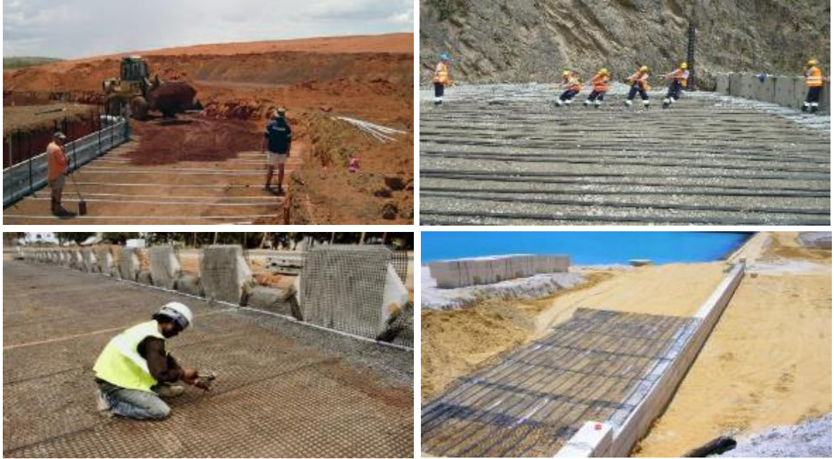
Şekil 1. Şerit veya Tabaka Halinde Serilen, Çelik veya Polimerden İmal Edilmiş Çeşitli Donatılı Zemin Duvarı Örnekleri
