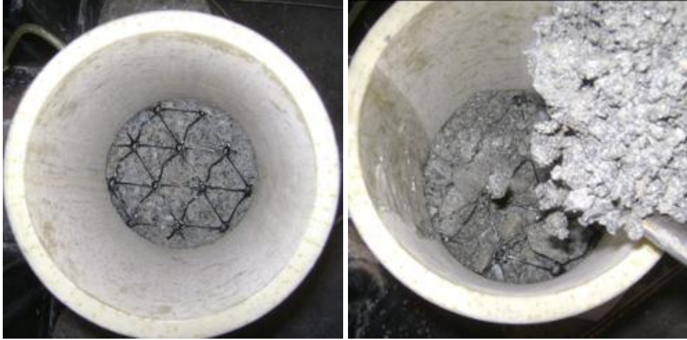
Şekil 7. Temel Zeminini İçerisine Geogrid Yerleştirilmesi
