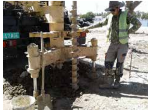
Şekil.1. Klasik Sürekli Burgu Yöntemi İle Sondaj Yapılması
