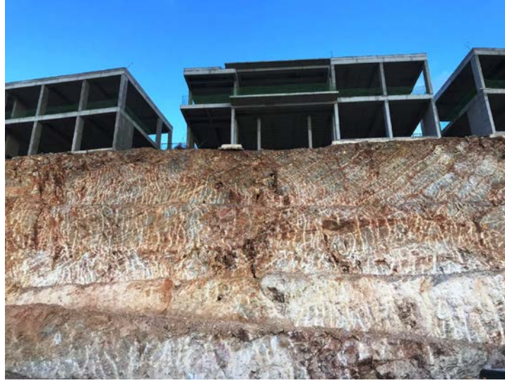
Şekil 8. Geoarme Teşkil için Hazırlanmış Kazı Yüzeyi
