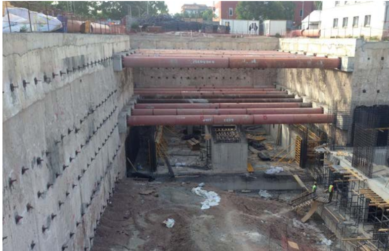
Şekil 3. Proje alanında uygulanan çelik boru destekli sistemi
