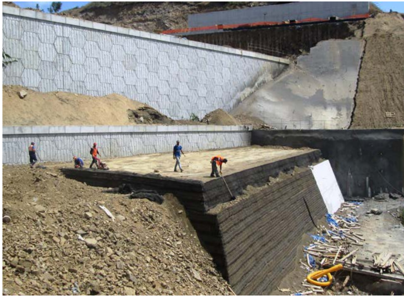
Şekil 11. Toprakarme Önündeki Geoarme İmalatı
