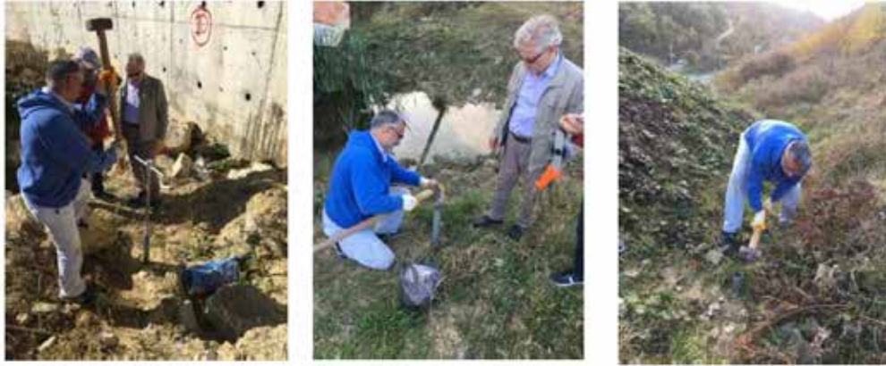
Şekil 8. Devrek Heyelan Bölgesinde Tüp Numunesi Alınan Yerler ve Numune Alma İşlemleri
