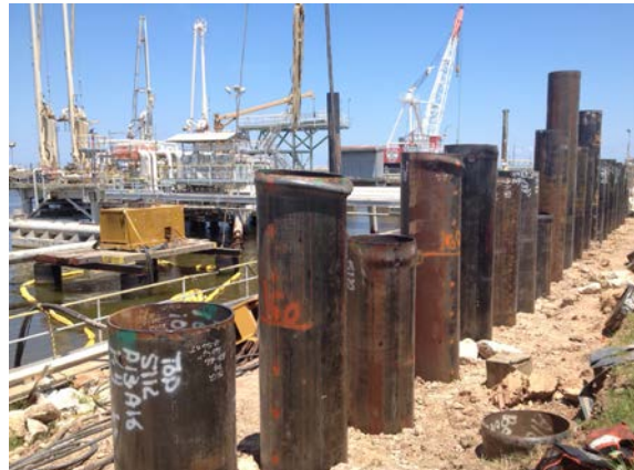
Şekil 6. Kazık Çakımından Sonra Taşkın Duvarının Görüntüsü
