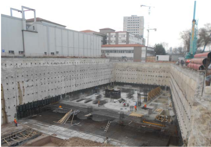
Şekil 5. Proje alanında uygulanmış ankraj destekli sistem
