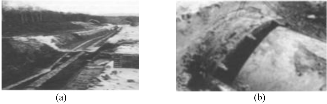
Şekil 1: 1993 Hokkaido-Nansei-Oki Depreminde (M=7.8) Boru Hatlarında Görülen Hasarlar a) Yüzeğe Çıkan Boru Hattı (100 cm yukarı çıkmıştır) b) Borunun Bağlantı Noktasından Ayrılması (Tani vd., 1995)
