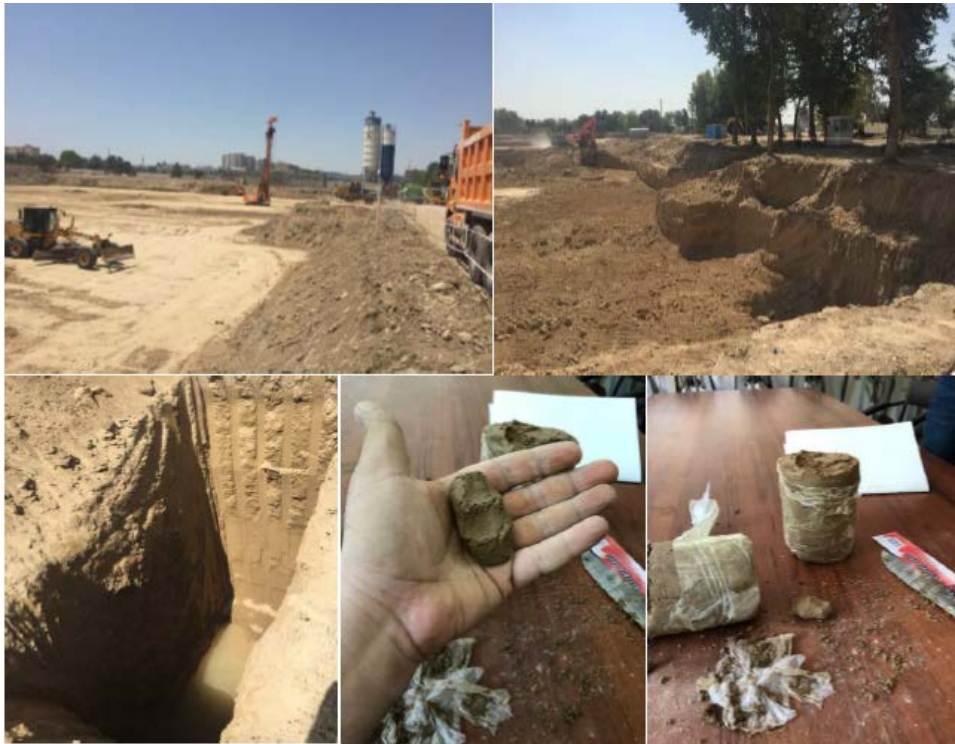
Şekil 2. Proje Sahası Zemini
