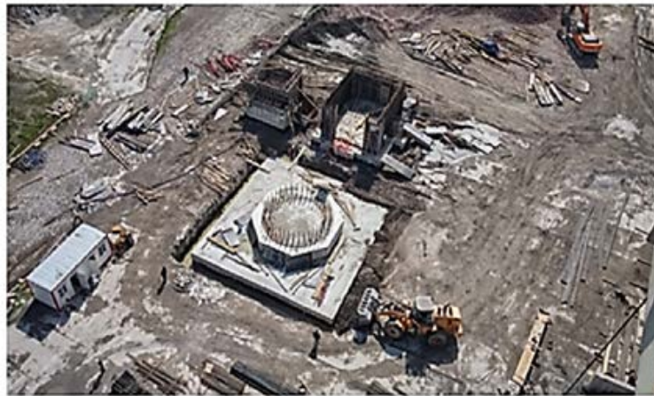
(c) Yapı temel sisteminin imalatına ait görsel
