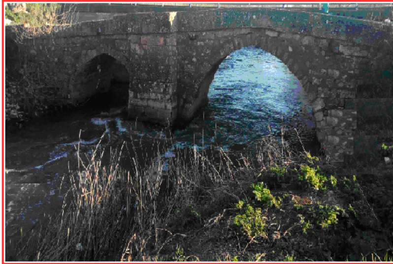
Şekil 1. Çalışmada Araştırılan Tarihi Yığma Yapılı Kemer Köprü.
