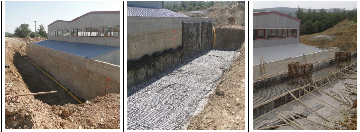
Şekil 2. Mevcut istinat duvarı arkasının geogrid ile güçlendirilme aşamaları
