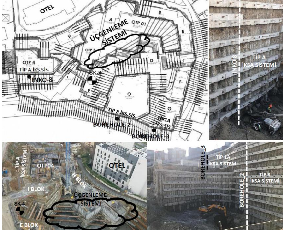
Şekil 2. İksa yerleşim planı ile ankraj ve çelik elemanlarla desteklenmiş sistem imalat görünüşleri
