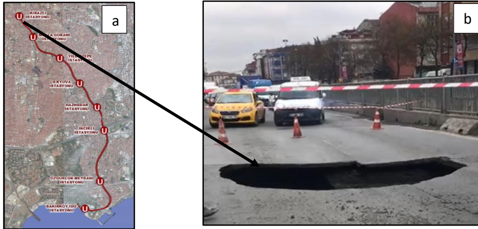
Şekil 1. (a) Bakırköy- Bahçelievler- Kirazlı Metro Hattı (M3) haritası. (b) Kirazlı istasyonu 600 m güneyinde yüzeye kadar ulaşan bir zemin boşalması
