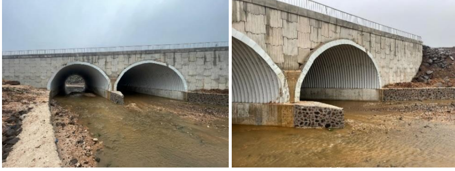
Şekil 8. Viranşehir köprüsünün mevcut hali
