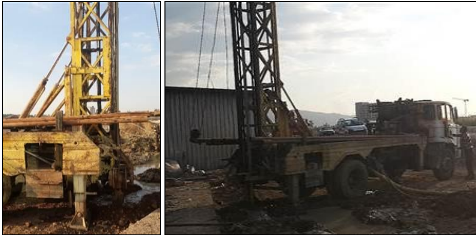
Şekil 3. Reaksiyon kazıkları delgi aşaması
