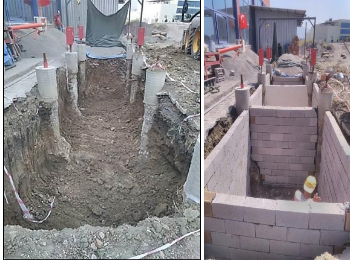
Şekil 7. Deney havuzlarının kazı aşaması ve duvar imalatları
