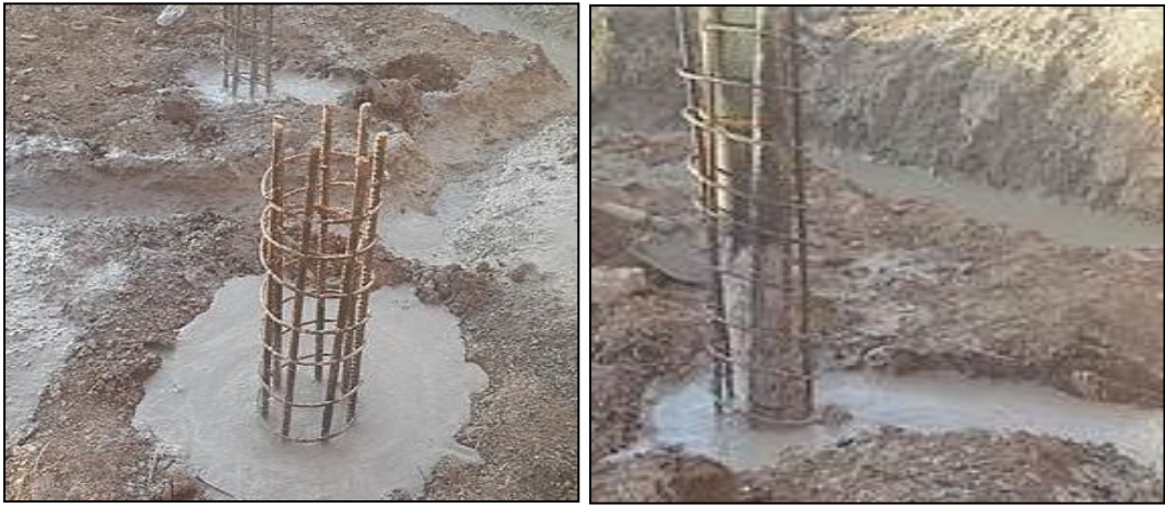
Şekil 5. Reaksiyon kazıklarında betonlama işlemi
