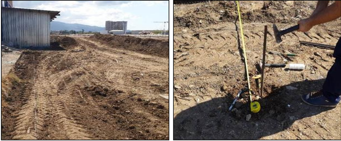
Şekil 2. Arazi ortamı yüzey düzeltmesi ve kazık yerlerinin işaretlenmesi
