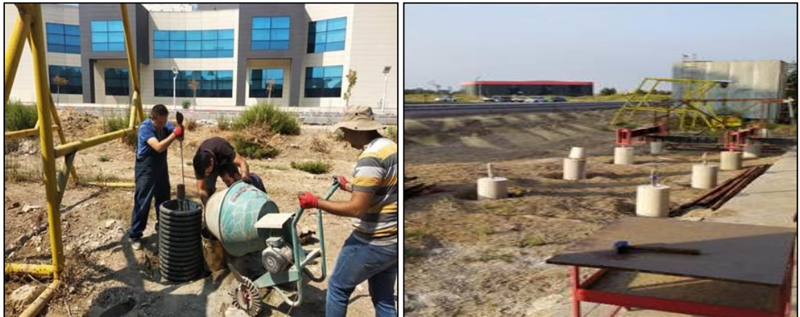
Şekil 6. Reaksiyon kazıklarında başlık betonu imalatı
