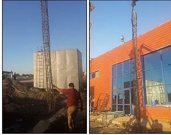
Şekil 4. Reaksiyon kazıklarında donatıların delgi içerisine yerleştirilmesi
