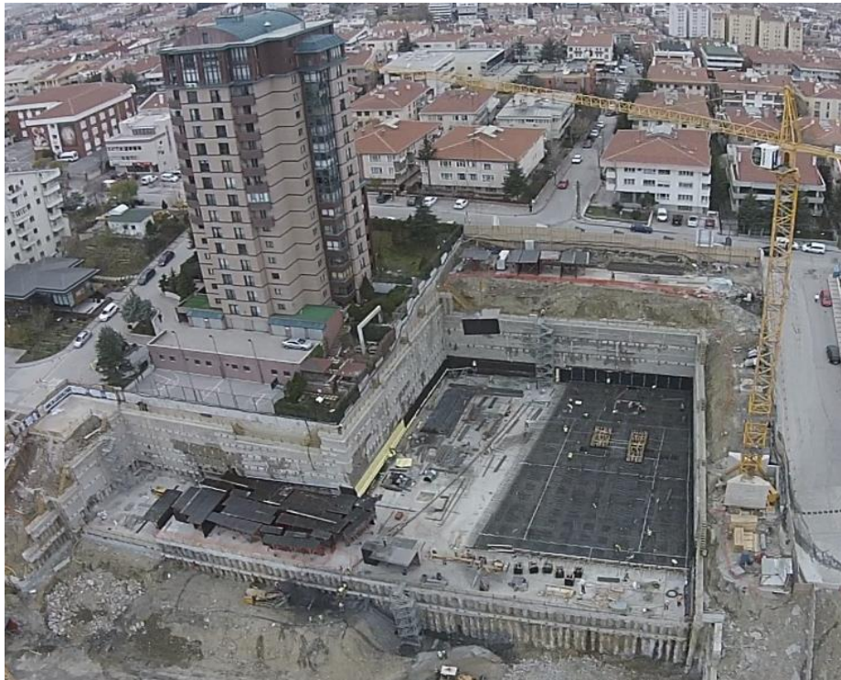
Şekil 2. Kazının Tamamlanmaya Yakın Durumdaki Görünümü
